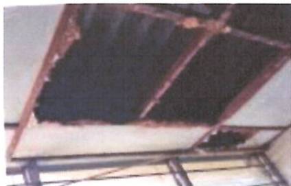
Foto 1: Sustrucción de cielo falso, con sus respectivos soportes y accesorios en aula y dirección
