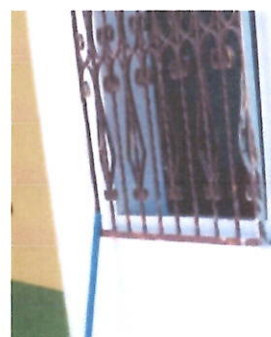
Foto 4: Sustrucción de ventanas; sistema de apertura: Corredizas, Perfiles color blanco estandar, Material del marco: PVC Material de la ventana: Vidrio, sellado perimetral, en área de dirección,
