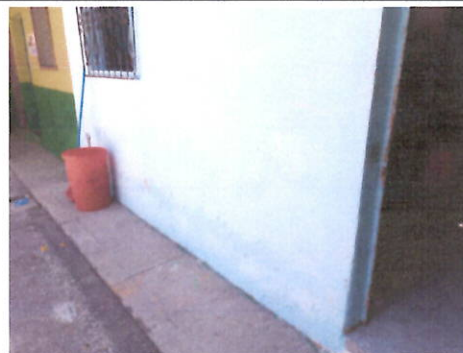
Foto 6: Reparación de repello y cernido en muro de mampostería con aplicación de acabado uniforme en fachada de dirección
