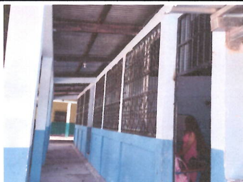
Foto 3: Preparación de la superficie y aplicación de pintura a dos manos, en paredes interiores y exteriores del establecimiento y sanitario.
