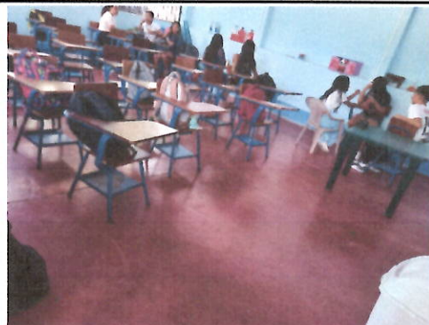
Foto 2: Sustrucción de piso de acabado liso, por piso cerámico en módulo de aulas, dirección y sanitario.
