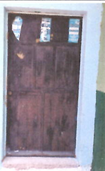
Foto 5: Mantenimiento a puerta metálica existente retiro de óxido, suciedad y pintura deteriorada; incluye cepillado, lijado y aplicación de pintura.
